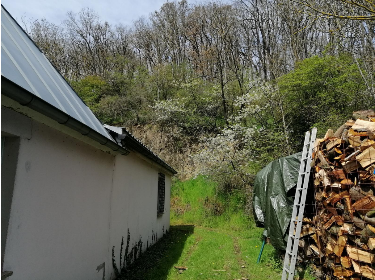
Abb. 7: Bestandsgebäude mit anschließender Felswand und Waldrand
