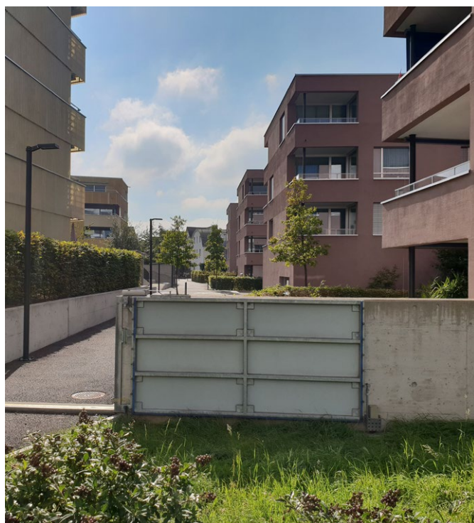
Abb. 66: Baulicher Überflutungsschutz Wohnhäuser, Zürich
