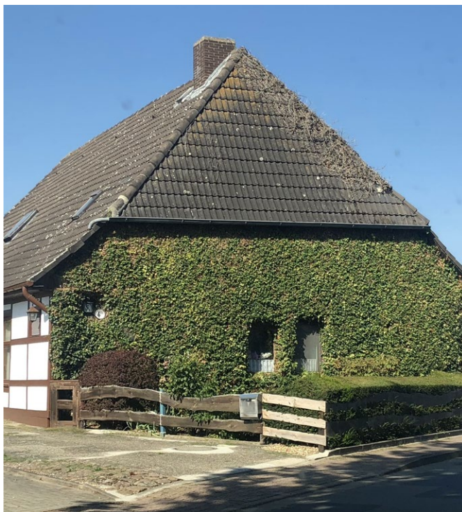
Abb. 61: Fassadenbegrünung an einem Wohnhaus, Ribbesbüttel
