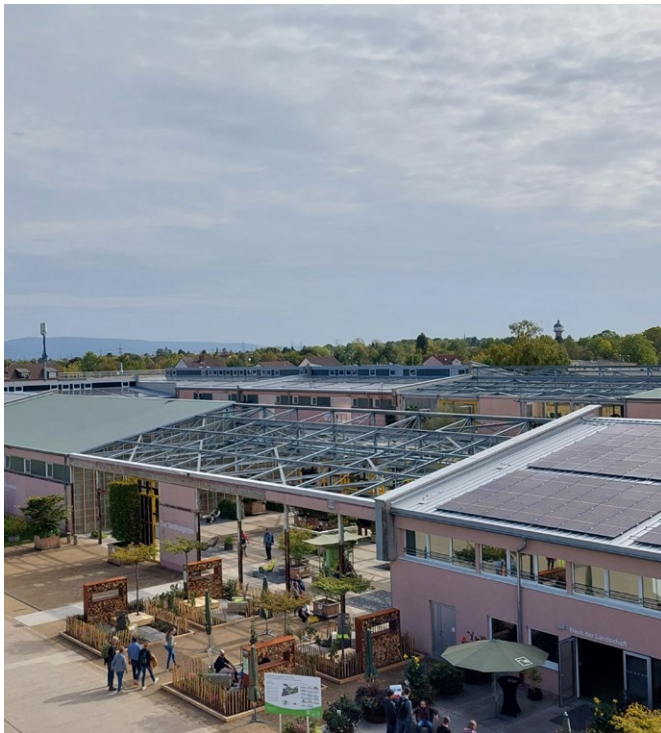
Abb. 43: Teilabbruch Gebäude zugunsten Kaltluftströmung, Mannheim
