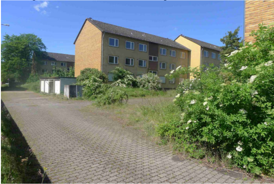
Abbildung 15: Bereich im Inneren der Siedlung
