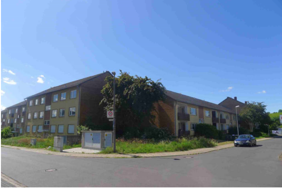
Abbildung 13: Blick auf das Plangebiet von der Ecke `Amselweg`/ `Dammstraße`
